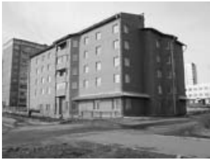
22-квартирный жилой дом (кирпичный), общая площадь — 1894 кв. м, ул. Лыжная («Кукковка») 2000 г.
