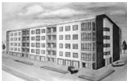
36-квартирный жилой дом со встроенными автостоянками, ул. Станционная («Голиковка»)
